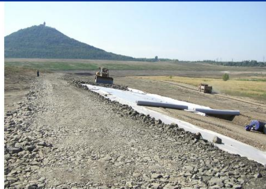
Výstavba břehové linie
